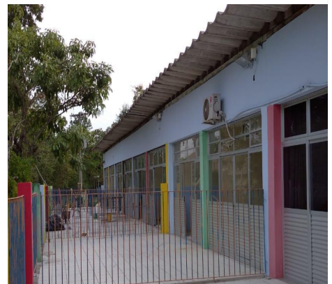
Troca das portas de madeira por esquadrias de alumínio
