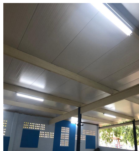
Substituição das telhas antigas por telhas termoacústicas
