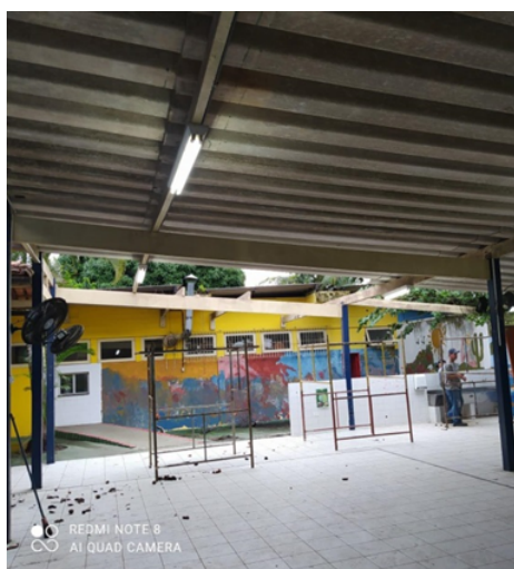
Substituição das telhas antigas por telhas termoacústicas
