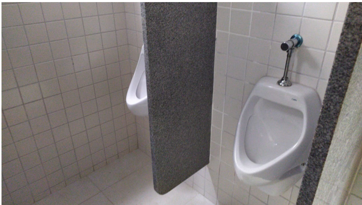
Foto 4 – Banheiro masculino do andar térreo do prédio do PPGE (2019)
